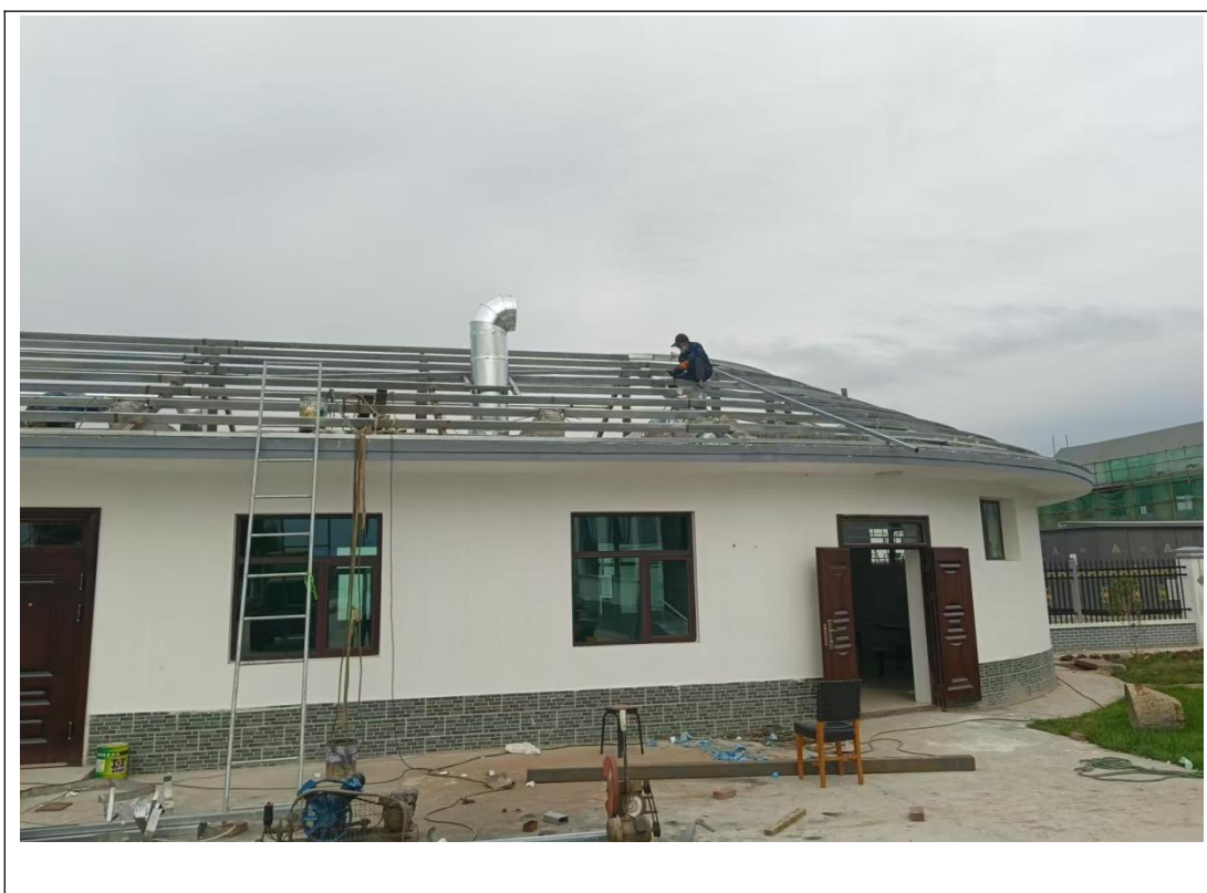
图 3-6-1 地块内现场情况一览表
