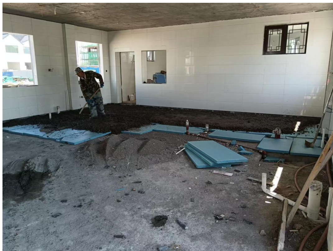
临泽县鸭暖镇屯泉小学食堂建设项目地块现状图
