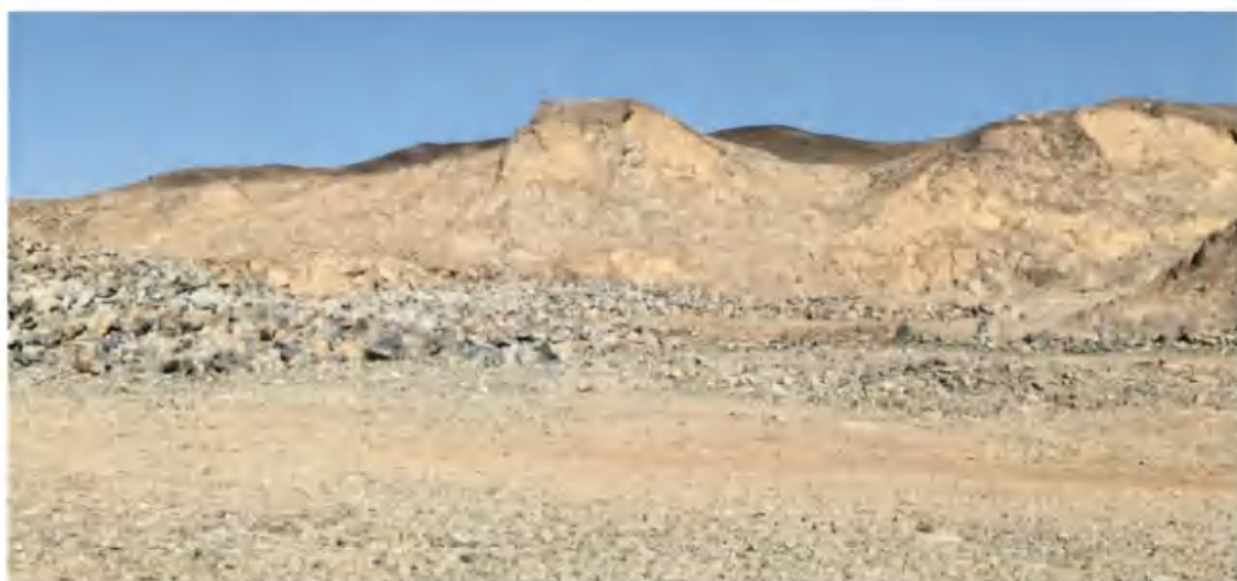
露天采场边坡现状照片
